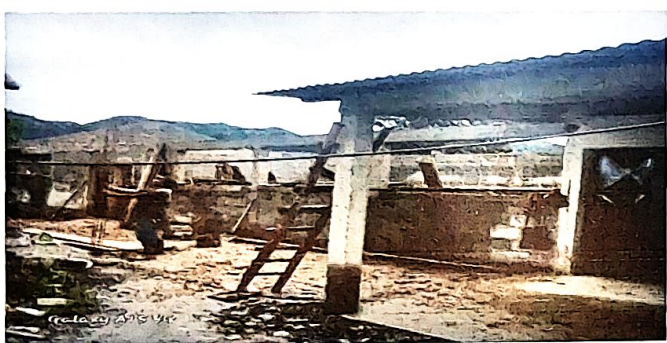
Avance de la rehabilitación de muro de contención modulo 2.
