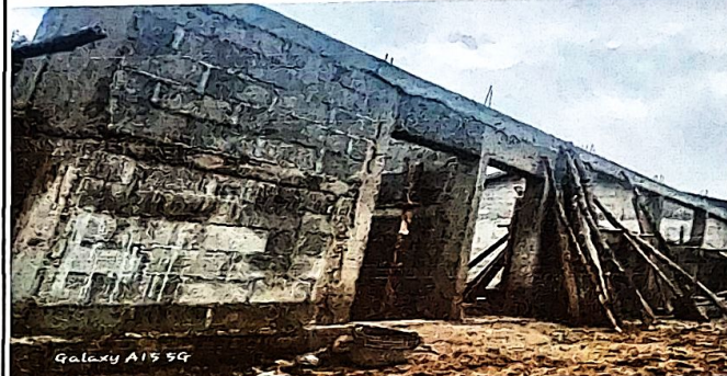
Medición de puertas y ventanas modulo 2.
