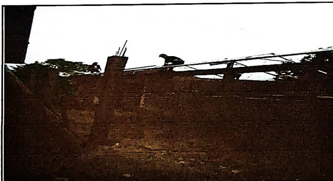
Instalación de estructuras metálicas y enlaminado modulo 2.
